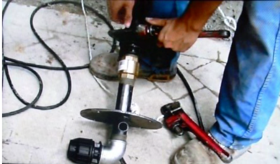
Dispositif en tête de puits
