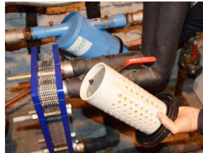
Le filtre 120 mesh (ouverture de maille = 125 microns) et sa cartouche filtrante à tourbillon de marque Kulker
