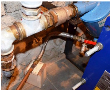
Le circuit d'eau sous pression pour décolmatage filtre
