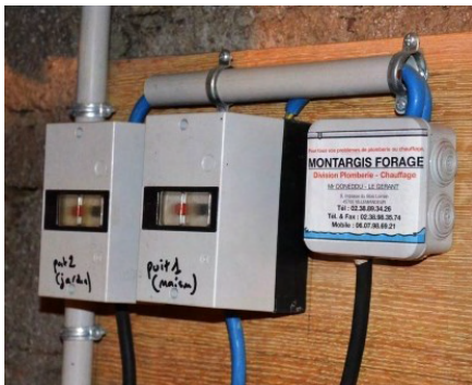
La commande des pompes immergées
