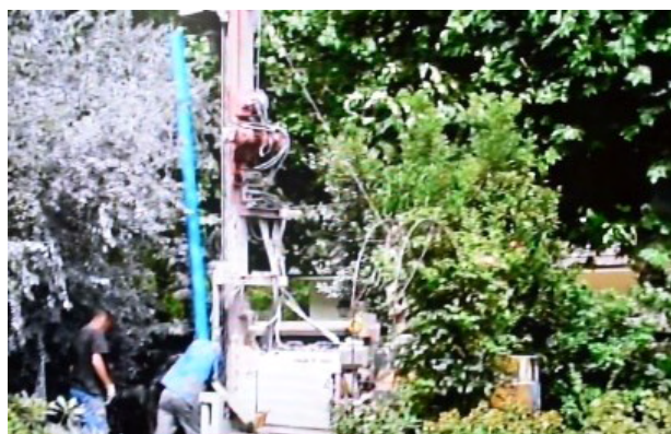
Engagements des longueurs de tubes PVC vissés en partie basse
