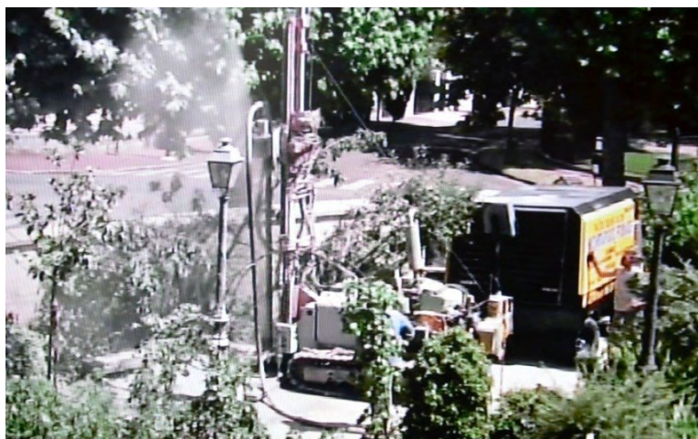
Rejet des sédiments pendant le forage par un compresseur d'air sur la droite
