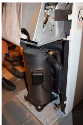
Le compresseur spiral type Scroll de la PAC capot d'insonorisation démonté
