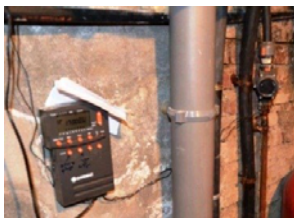
Le circuit d'eau sous pression pour décolmatage filtre
