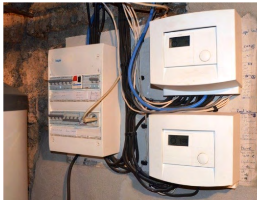
La commande des pompes immergées
