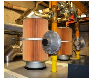
Le sous-ensemble de désembouage** assure la filtration en continue du circuit chauffage
