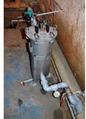
Le sous-ensemble de désembouage** assure la filtration en continue du circuit chauffage
