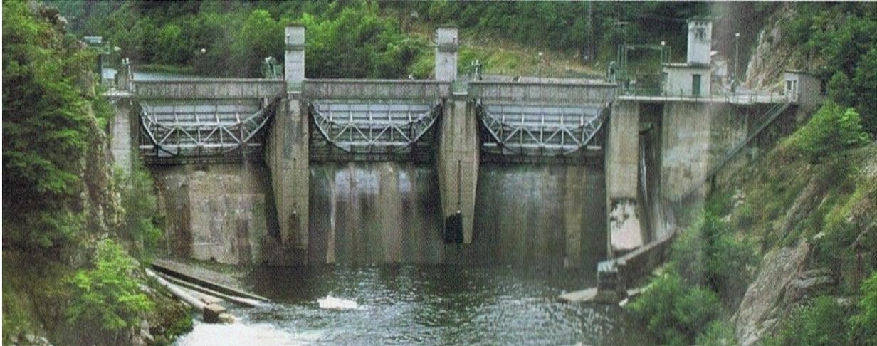
*Le barrage de Poutès sur le haut Allier tel qu'il est représenté sur cette photo peut être considéré actuellement avec sa retenue de 3 km de long comme un grand "barrage à lac". Il pourrait être transformé dans les années qui viennent par l'EDF en « barrage au fil de l'eau »*
