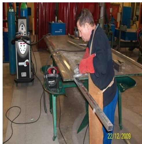
Figure 65 : Ebavurage des soudures par abrasion
