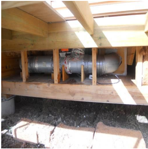
Figure 98 : vue de l'assemblage du circuit aéraulique aval
