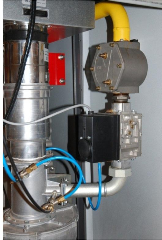
2) Arrivée d'air de combustion et de gaz naturel avec les variateurs assurant une plage de 20 à 100% en puissance de chauffe
