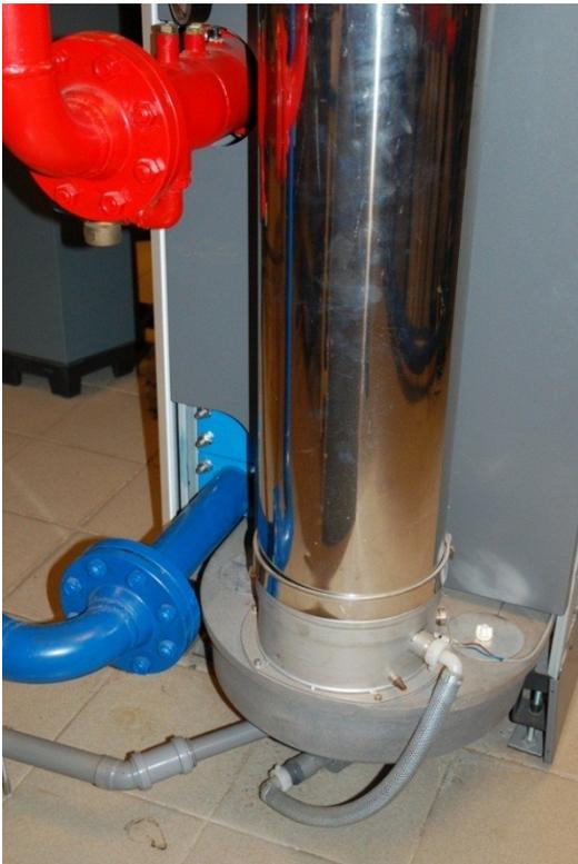
3) Evacuation des gaz brulés en inox. On remarque la possibilité de prévoir deux retours (tuyauterie bleu) Evacuation du condensat en bas à droite Nota caractéristique intéressante le dispositif de condensation est incorporé aux chaudières
