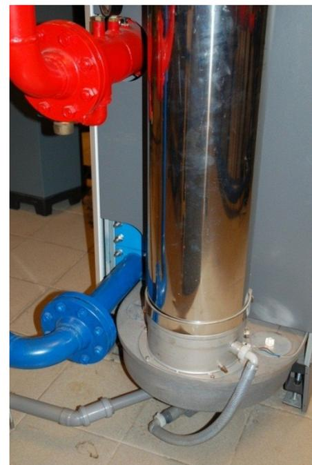
La chaufferie gaz serait composé de deux chaudières De Dietrich C610700 comme celle montrée sur la photo de gauche mais assemblée l'une sur l'autre. Sur la figure centrale l'arrivée d'air de combustion et de gaz naturel avec les variateurs assurant une plage de 20 à 100% en puissance de chauffe. Evacuation des gaz brûlés en inox. On remarque sur la figure de droite, la possibilité de prévoir deux retours (tuyauterie bleu) avec évacuation du condensat en bas sur cette figure
