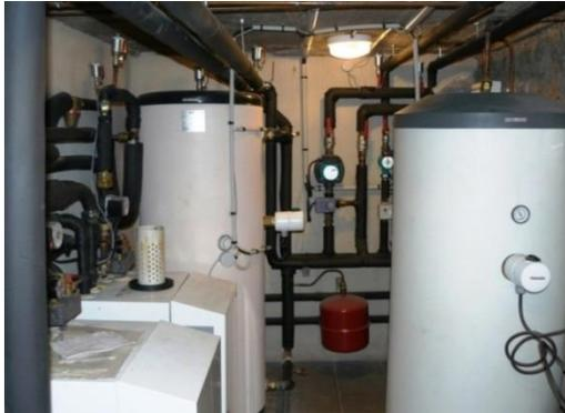
Les deux ballons chauffage et ECS et les deux PAC (en bas à gauche)
