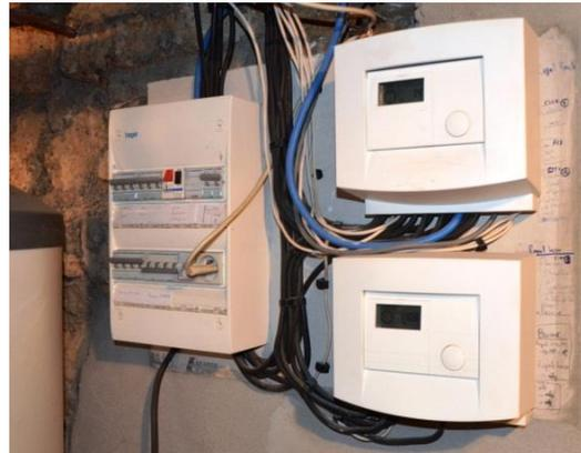
Sur la droite, la régulation électronique, qui déclenche dans le bon ordre les deux pompes immergées, les deux PAC et les vannes trois voies de régulation du chauffage central.
