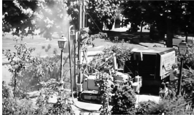
Rejet des sédiments pendant le forage par un compresseur d'air sur la droite
