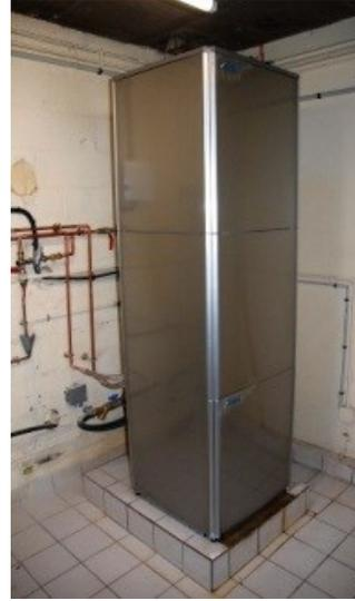
La Partie source chaude de la pompe à chaleur disposée sur le socle de l'ancienne chaudière fioul
