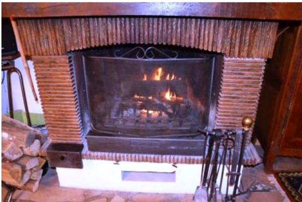
*Le flux thermique de la soufflante d'air chaud située sous le foyer ouvert est cumulatif avec celui du chauffage gaz diminuant la consommation en énergie fossile.*
