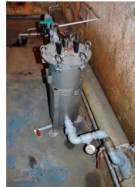
Le sous-ensemble de désembouage 4 assure la filtration en continue du circuit chauffage.
