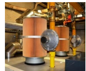
Le sous-ensemble de désembouage 4 assure la filtration en continue du circuit chauffage.
