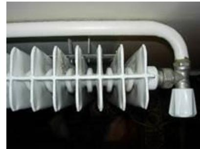
Compte tenu de l'épaisseur de 9 cm et de l'espacement des ailettes de 3 cm, la surface totale de rayonnement de ces radiateurs est sensiblement égale à la surface frontale x 4.
