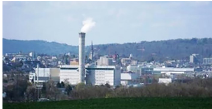
Centrale de 40 MW assurant le chauffage urbain par la combustion des ordures dans la proche banlieue de Zurich
