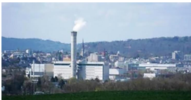
Centrale de 40 MW assurant le chauffage urbain par la combustion des ordures dans la proche banlieue de Zurich
